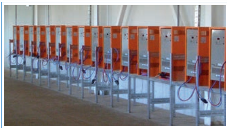
Стеллажи для зарядных устройств
