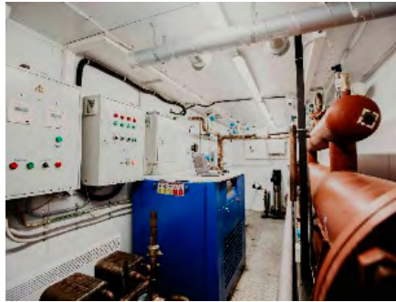
Компоновка ГеоЭС 25 кВт
